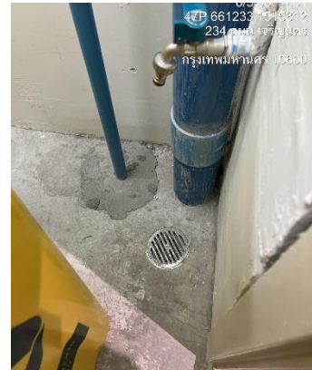
รูปที่ 46 ท่อรวบรวมน้ำจากการล้างห้องพักขยะมูลฝอย
