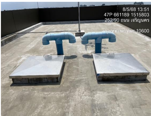
รูปที่ 6 ถังสำรองน้ำใช้ชั้นใต้ดิน และถังสำรองน้ำชั้นดาดฟ้า
